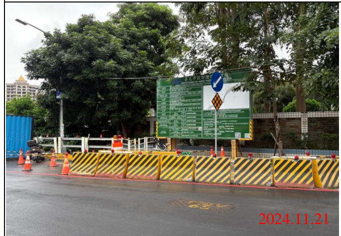
巡查日期地點：113.11.21/ Y23車站 照片說明：牌面設置狀況
