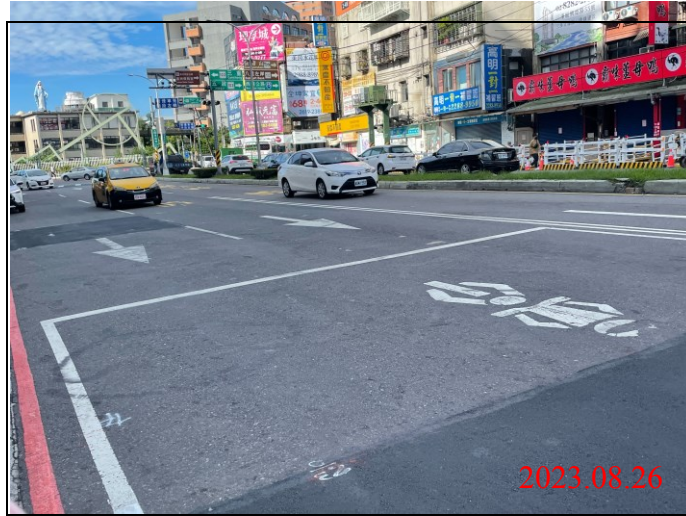
巡查日期地點：112.08.26/ Y21車站 照片說明：路面狀況
