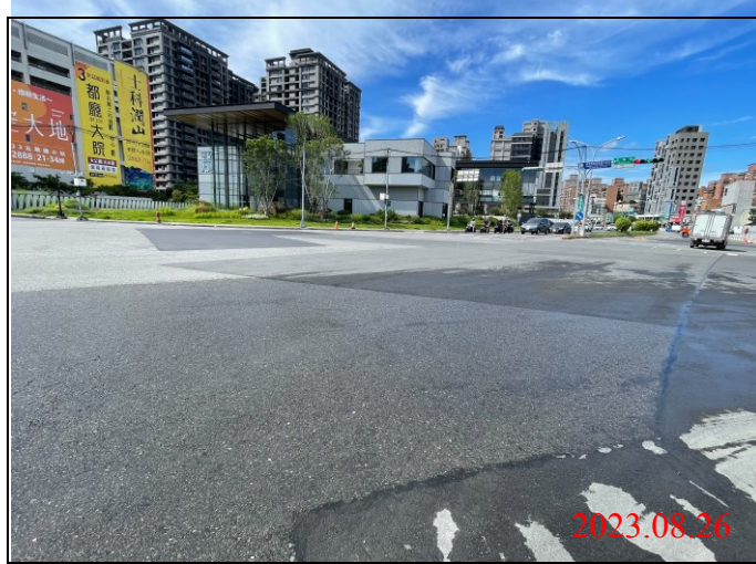
巡查日期地點：112.08.26/ Y22車站 照片說明：路面狀況
