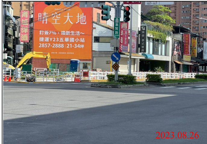
巡查日期地點：112.08.26/ Y21車站 照片說明：路面狀況
