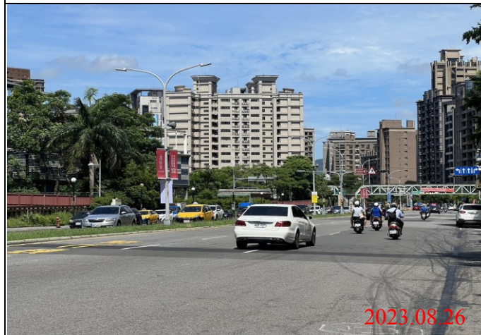
巡查日期地點：112.08.26/ Y23車站 照片說明：路面狀況
