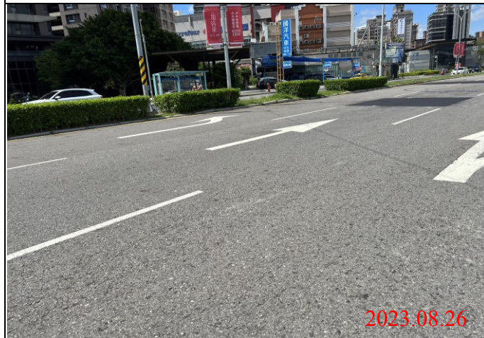
巡查日期地點：112.08.26/ Y22車站 照片說明：路面狀況
