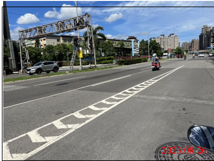
巡查日期地點：112.08.26/ Y23車站 照片說明：路面狀況
