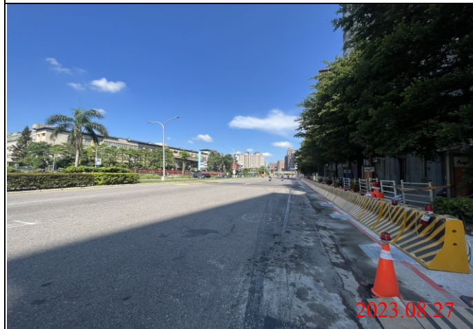
巡查日期地點：112.08.27/ Y23車站 照片說明：路面狀況
