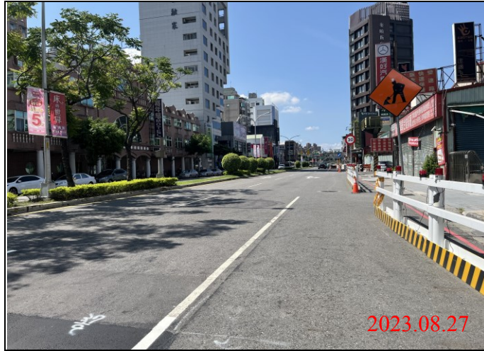
巡查日期地點：112.08.27/ Y21車站 照片說明：路面狀況
