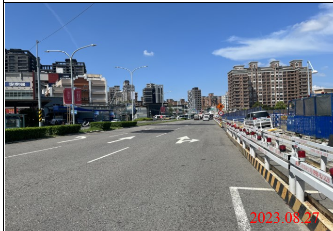
巡查日期地點：112.08.27/ Y22車站 照片說明：路面狀況
