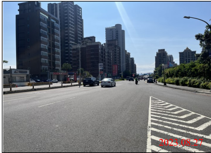
巡查日期地點：112.08.27/ Y23車站 照片說明：路面狀況
