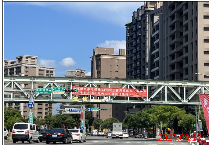
巡查日期地點：112.08.27/ Y23車站 照片說明：牌面設置狀況
