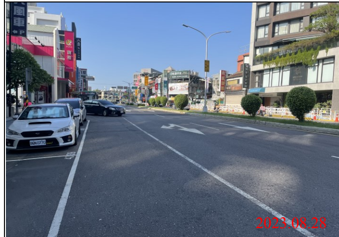
巡查日期地點：112.08.28/ Y21車站 照片說明：路面狀況
