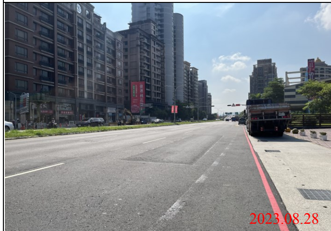
巡查日期地點：112.08.28/ Y23車站 照片說明：路面狀況
