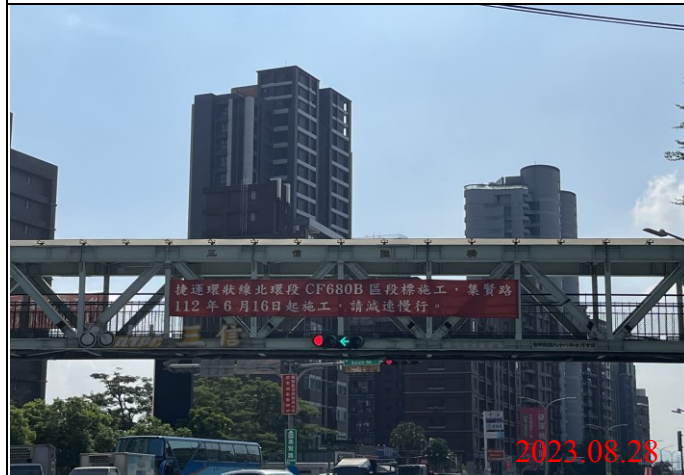
巡查日期地點：112.08.28/ Y23車站 照片說明：牌面設置狀況
