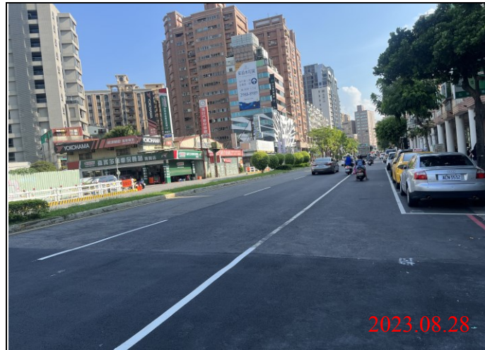
巡查日期地點：112.08.28/ Y21車站 照片說明：路面狀況
