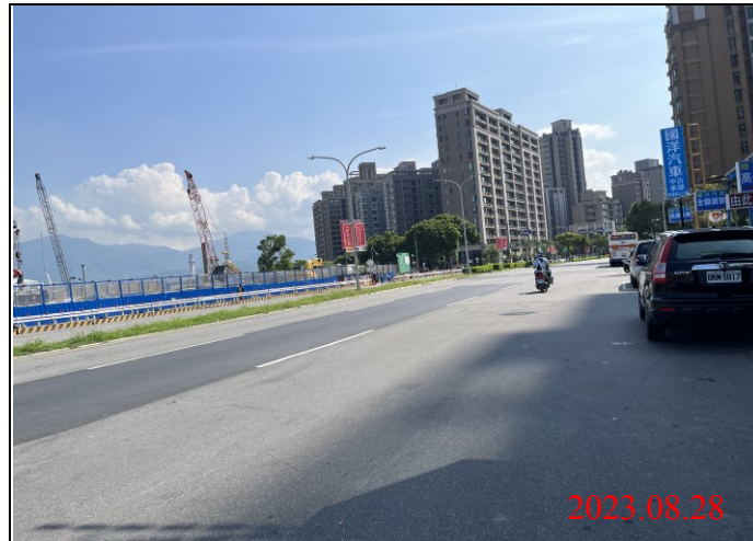
巡查日期地點：112.08.28/ Y22車站 照片說明：路面狀況
