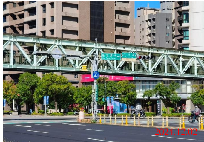
巡查日期地點：113.12.02/ Y23車站 照片說明：牌面設置狀況
