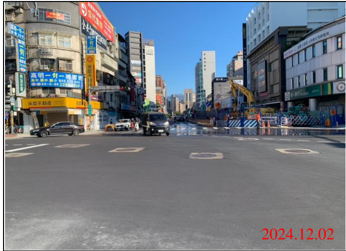
巡查日期地點：113.12.02/ Y21車站 照片說明：牌面設置狀況
