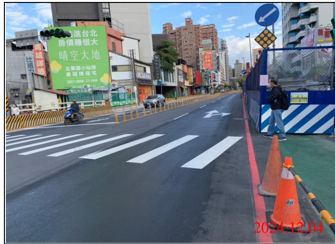
巡查日期地點：113.12.04/ Y21車站 照片說明：牌面設置狀況
