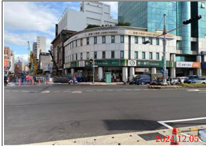
巡查日期地點：113.12.05/ Y21車站 照片說明：牌面設置狀況
