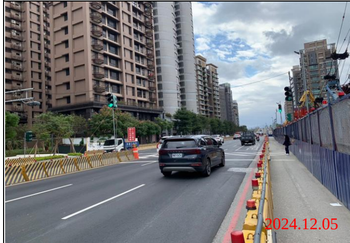
巡查日期地點：113.12.05/ Y23車站 照片說明：牌面設置狀況
