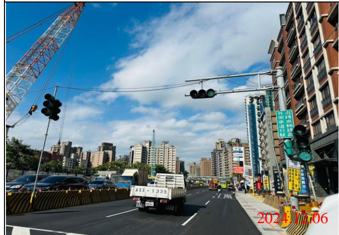
巡查日期地點：113.12.06/ Y23車站 照片說明：牌面設置狀況
