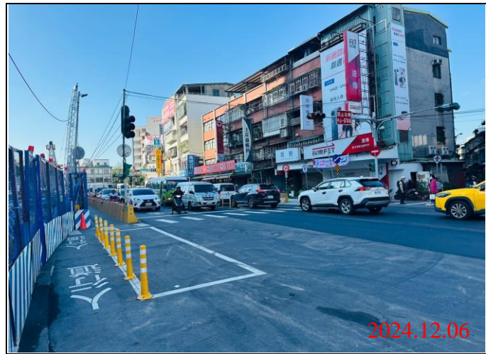
巡查日期地點：113.12.06/ Y21車站 照片說明：牌面設置狀況
