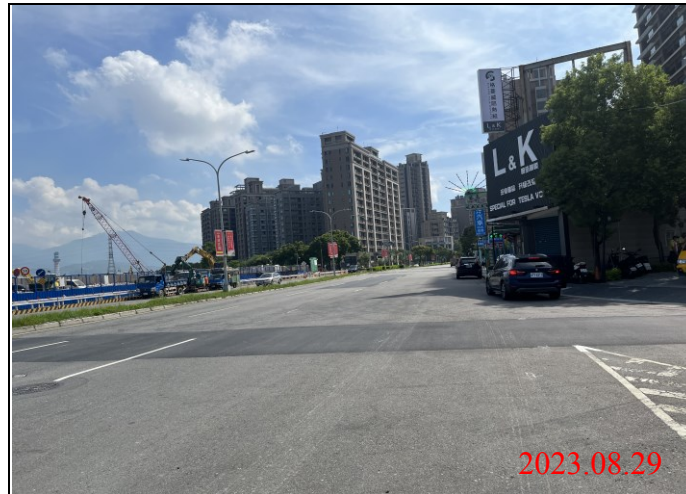
巡查日期地點：112.08.29/ Y22車站 照片說明：路面狀況
