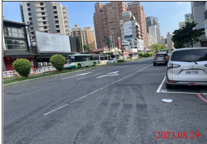
巡查日期地點：112.08.29/ Y21車站 照片說明：路面狀況
