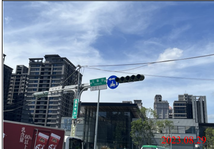
巡查日期地點：112.08.29/ Y22車站 照片說明：牌面設置狀況
