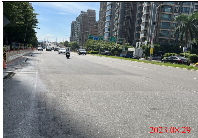
巡查日期地點：112.08.29/ Y23車站 照片說明：路面狀況
