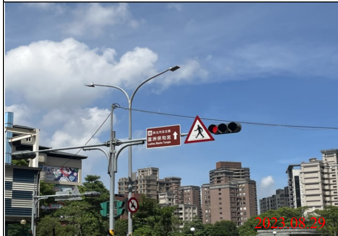
巡查日期地點：112.08.29/ Y23車站 照片說明：牌面設置狀況
