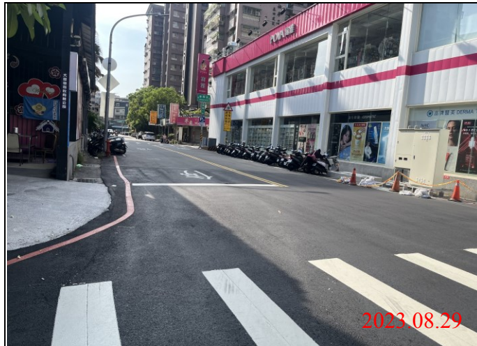
巡查日期地點：112.08.29/ Y21車站 照片說明：路面狀況
