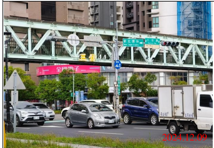
巡查日期地點：113.12.09/ Y23車站 照片說明：牌面設置狀況
