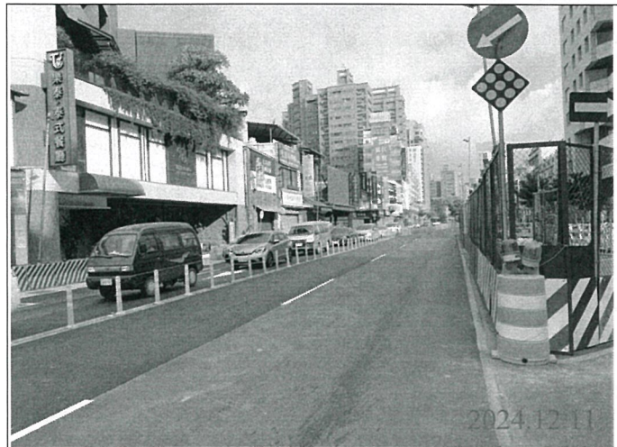
巡查日期地點：113.12.11/ Y21車站 照片說明：牌面設置狀況
