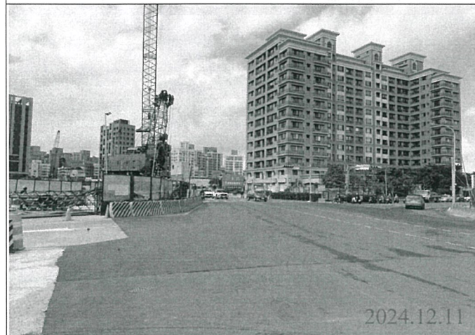
巡查日期地點：113.12.11/ Y22車站 照片說明：牌面設置狀況
