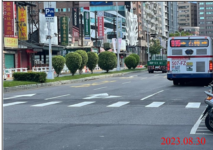
巡查日期地點：112.08.30/ Y21車站 照片說明：路面狀況
