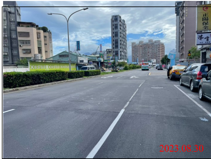
巡查日期地點：112.08.30/ Y22車站 照片說明：路面狀況
