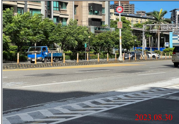
巡查日期地點：112.08.30/ Y23車站 照片說明：路面狀況
