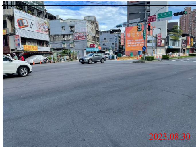
巡查日期地點：112.08.30/ Y21車站 照片說明：路面狀況
