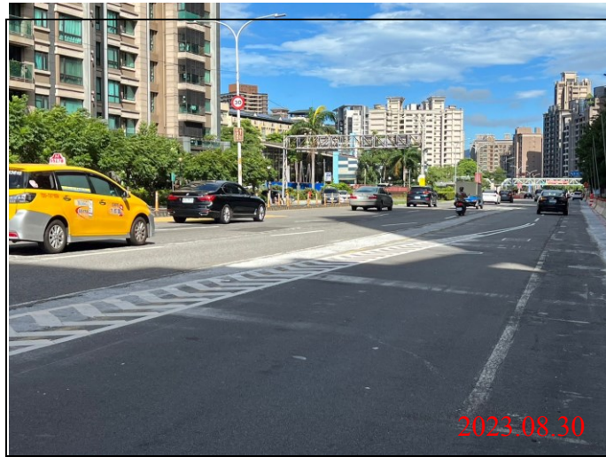
巡查日期地點：112.08.30/ Y23車站 照片說明：路面狀況
