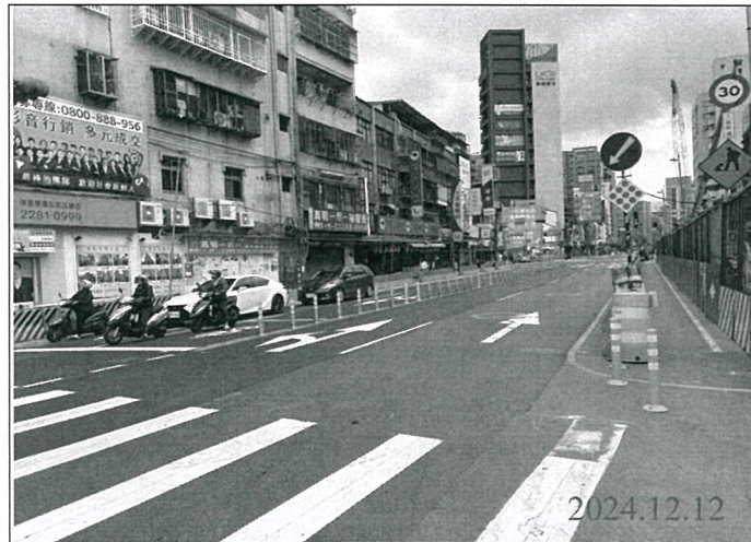
巡查日期地點：113.12.12/ Y21車站 照片說明：牌面設置狀況
