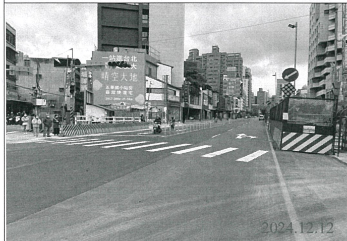
巡查日期地點：113.12.12/ Y22車站 照片說明：牌面設置狀況
