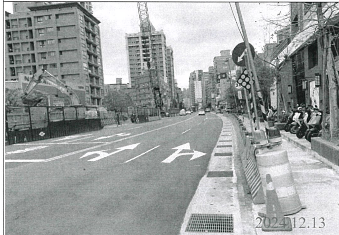
巡查日期地點：113.12.13/ Y22車站 照片說明：牌面設置狀況
