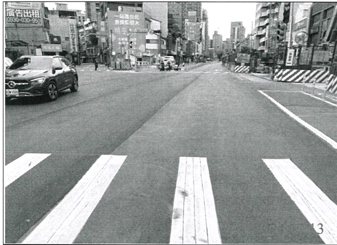
巡查日期地點：113.12.13/ Y21車站 照片說明：牌面設置狀況
