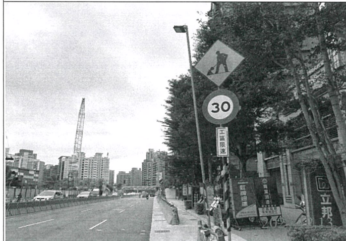
巡查日期地點：113.12.13/ Y23車站 照片說明：牌面設置狀況
