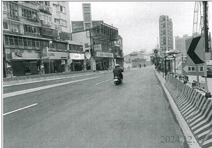
巡查日期地點：113.12.14/ Y22車站 照片說明：牌面設置狀況
