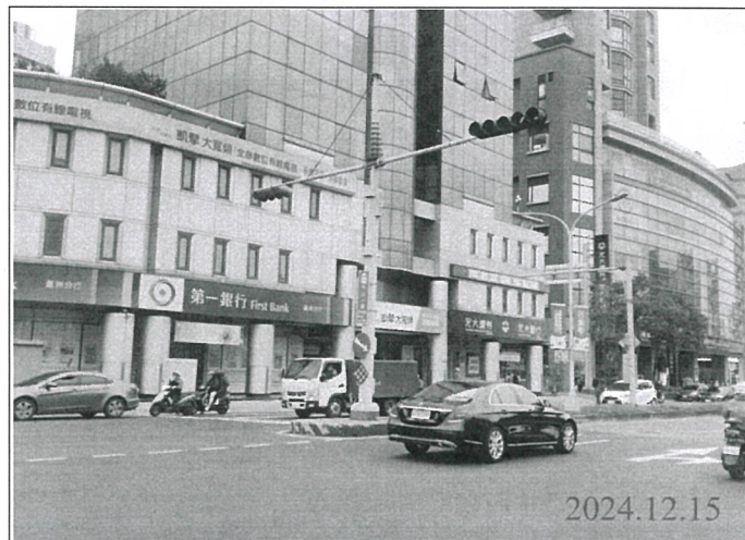
巡查日期地點：113.12.15/ Y21車站 照片說明：牌面設置狀況
