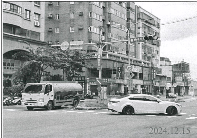
巡查日期地點：113.12.15/ Y22車站 照片說明：牌面設置狀況
