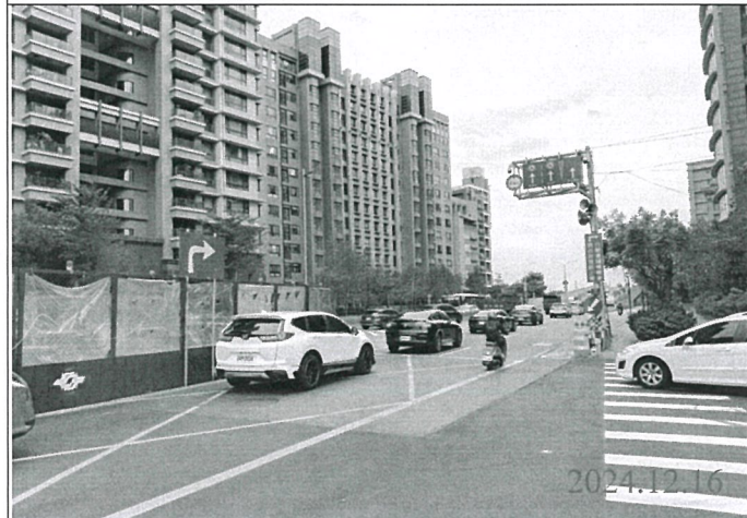
巡查日期地點：113.12.16/ Y23車站 照片說明：牌面設置狀況
