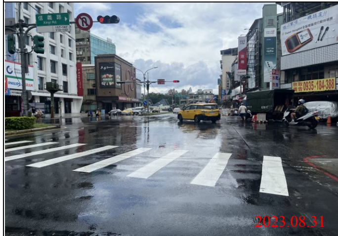
巡查日期地點：112.08.31/ Y21車站 照片說明：路面狀況
