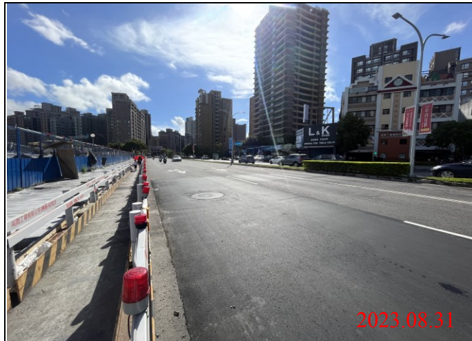
巡查日期地點：112.08.31/ Y22車站 照片說明：路面狀況
