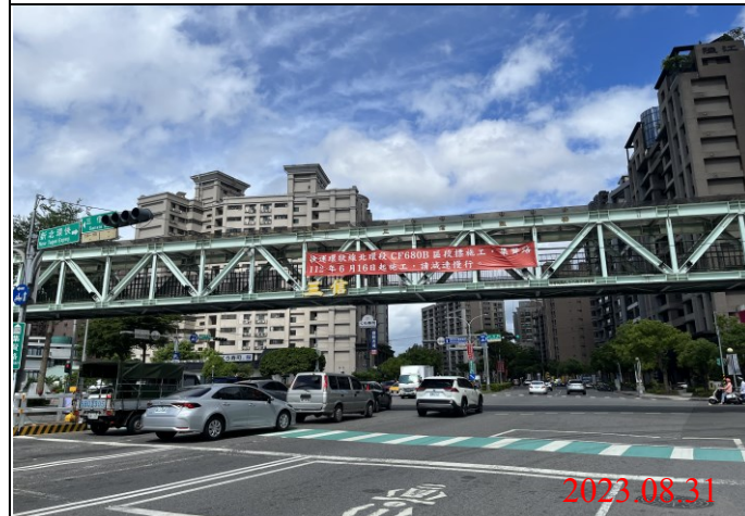
巡查日期地點：112.08.31/ Y23車站 照片說明：牌面設置狀況
