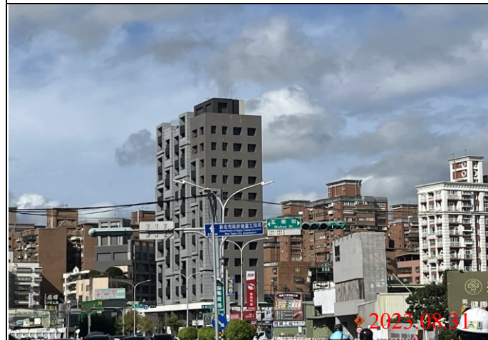
巡查日期地點：112.08.31/ Y22車站 照片說明：牌面設置狀況
