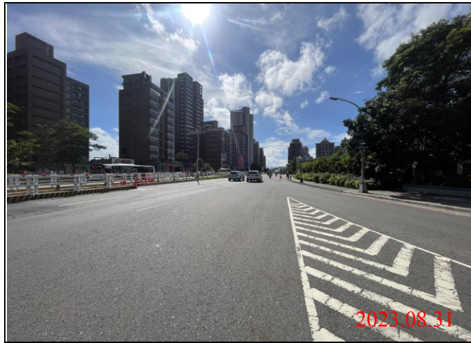
巡查日期地點：112.08.31/ Y23車站 照片說明：路面狀況
