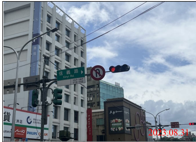
巡查日期地點：112.08.31/ Y21車站 照片說明：牌面設置狀況
