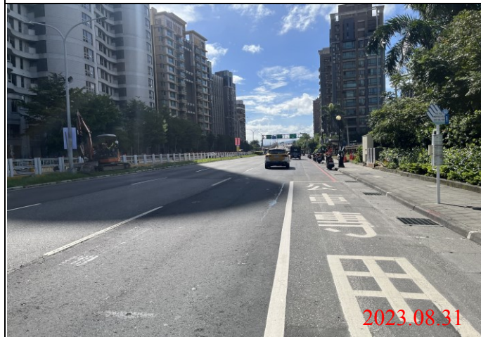
巡查日期地點：112.08.31/ Y23車站 照片說明：路面狀況
