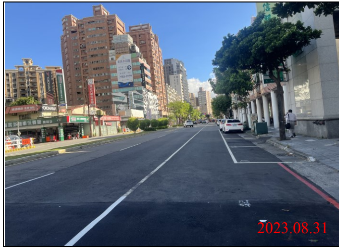
巡查日期地點：112.08.31/ Y21車站 照片說明：路面狀況
