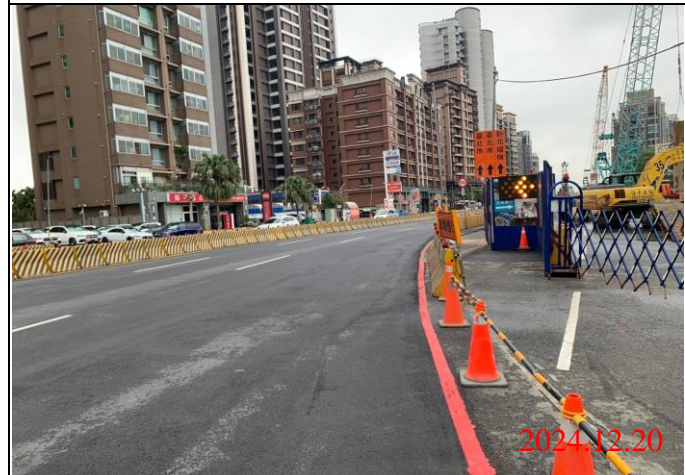
巡查日期地點：113.12.20/ Y23車站 照片說明：牌面設置狀況
