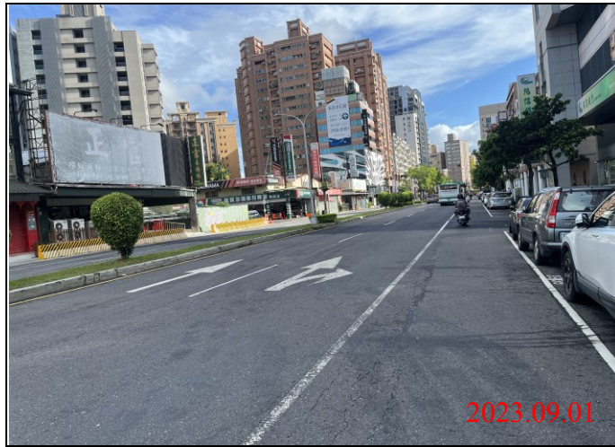
巡查日期地點：112.09.01/ Y21車站 照片說明：路面狀況
