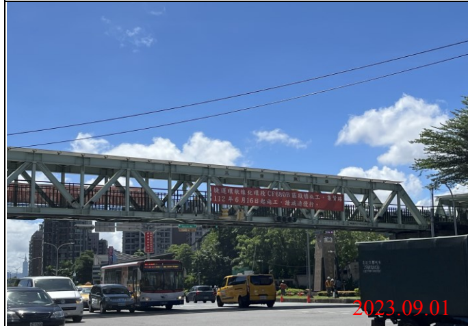
巡查日期地點：112.09.01/ Y23車站 照片說明：牌面設置狀況
