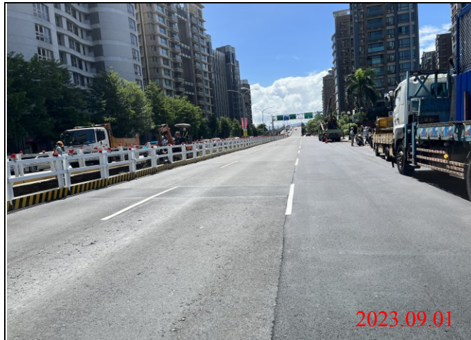
巡查日期地點：112.09.01/ Y23車站 照片說明：路面狀況
