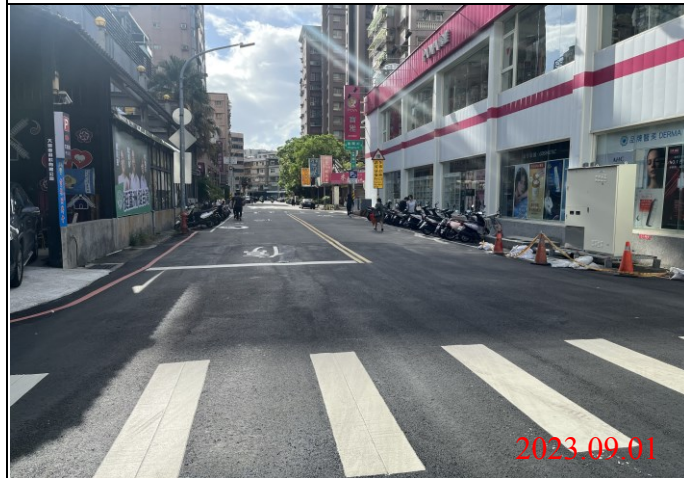
巡查日期地點：112.09.01/ Y21車站 照片說明：路面狀況
