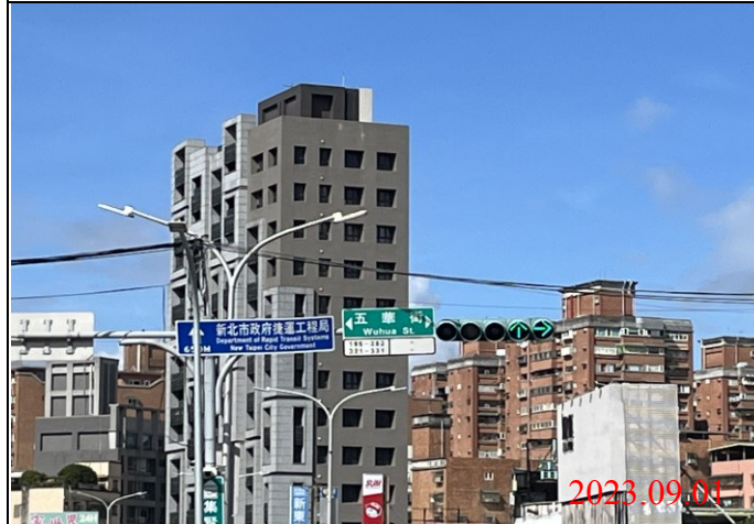
巡查日期地點：112.09.01/ Y22車站 照片說明：牌面設置狀況
