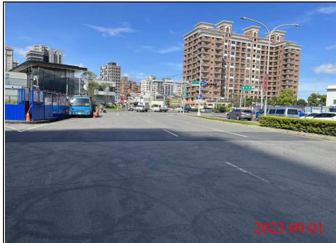
巡查日期地點：112.09.01/ Y22車站 照片說明：路面狀況
