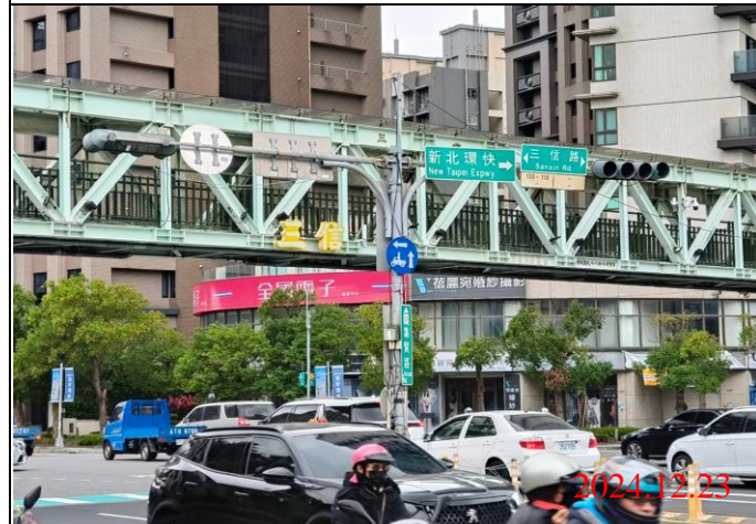
巡查日期地點：113.12.23/ Y23車站 照片說明：牌面設置狀況
