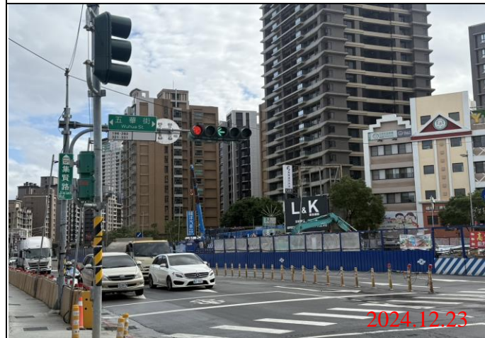
巡查日期地點：113.12.23/ Y22車站 照片說明：牌面設置狀況
