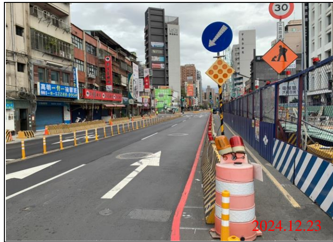
巡查日期地點：113.12.23/ Y21車站 照片說明：牌面設置狀況
