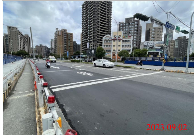
巡查日期地點：112.09.02/ Y22車站 照片說明：路面狀況
