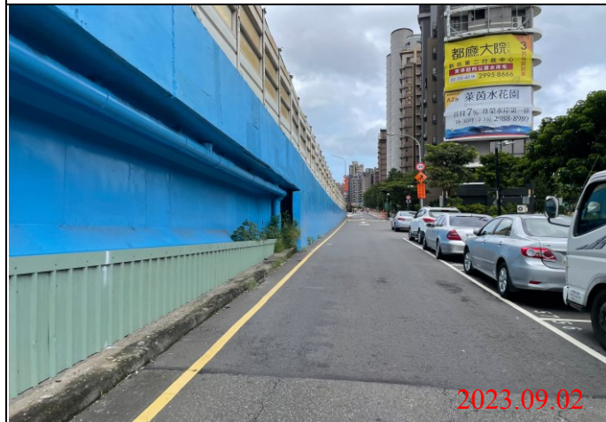
巡查日期地點：112.09.02/ Y23車站 照片說明：路面狀況
