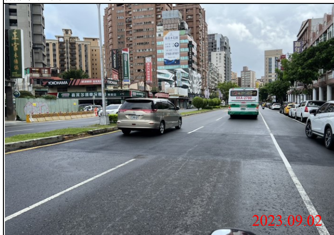
巡查日期地點：112.09.02/ Y21車站 照片說明：路面狀況
