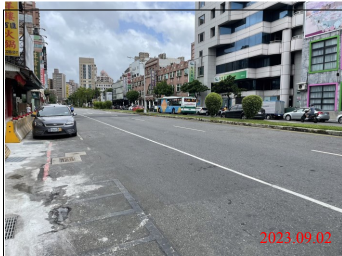
巡查日期地點：112.09.02/ Y21車站 照片說明：路面狀況
