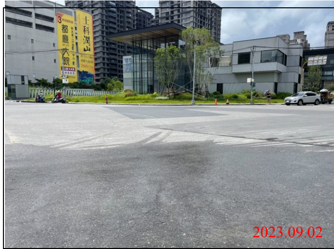
巡查日期地點：112.09.02/ Y22車站 照片說明：路面狀況
