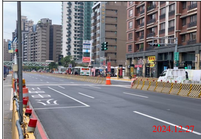
巡查日期地點：113.12.27/ Y23車站 照片說明：牌面設置狀況
