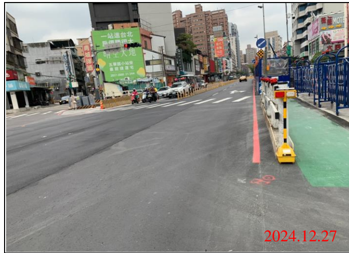
巡查日期地點：113.12.27/ Y21車站 照片說明：牌面設置狀況
