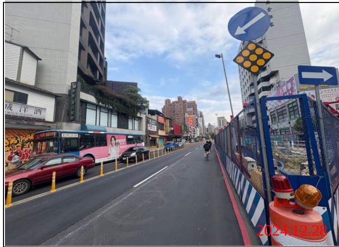
巡查日期地點：113.12.28/ Y21車站 照片說明：牌面設置狀況
