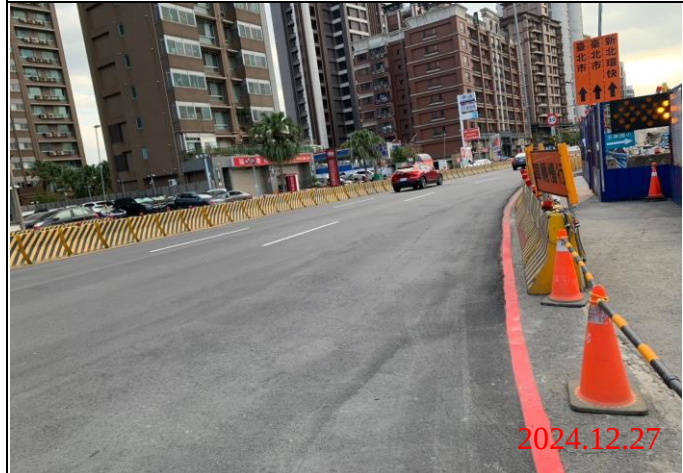
巡查日期地點：113.12.28/ Y23車站 照片說明：牌面設置狀況
