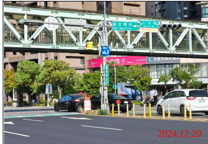
巡查日期地點：113.12.29/ Y23車站 照片說明：牌面設置狀況
