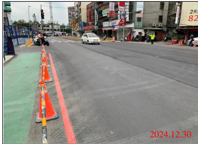
巡查日期地點：113.12.30/ Y21車站 照片說明：牌面設置狀況
