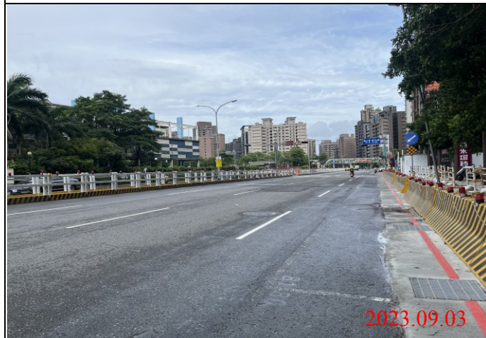
巡查日期地點：112.09.03/ Y23車站 照片說明：路面狀況
