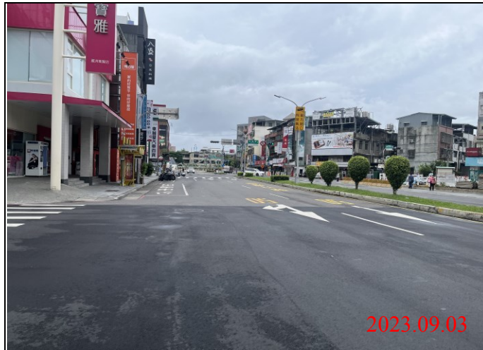
巡查日期地點：112.09.03/ Y21車站 照片說明：路面狀況
