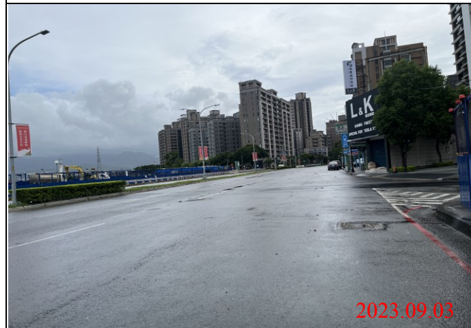
巡查日期地點：112.09.03/ Y22車站 照片說明：路面狀況
