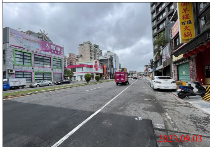
巡查日期地點：112.09.03/ Y21車站 照片說明：路面狀況
