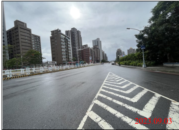
巡查日期地點：112.09.03/ Y23車站 照片說明：路面狀況
