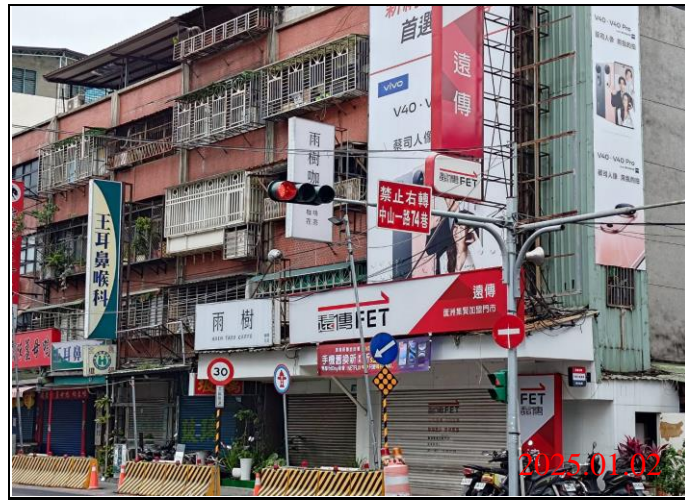
巡查日期地點：114.01.02/ Y21車站 照片說明：牌面設置狀況
