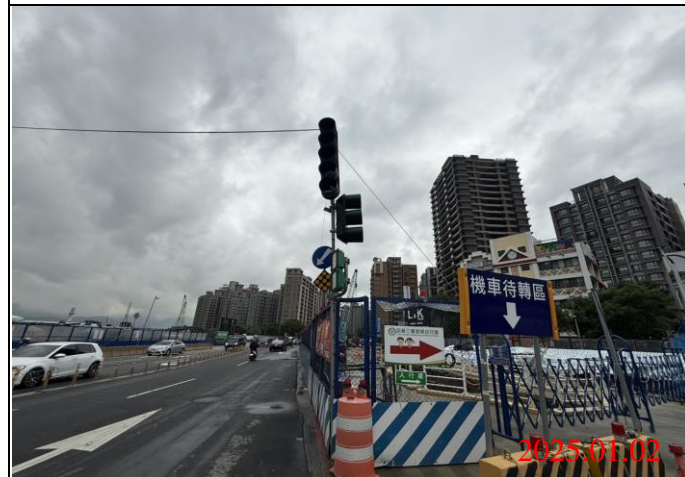
巡查日期地點：114.01.02/ Y22車站 照片說明：牌面設置狀況
