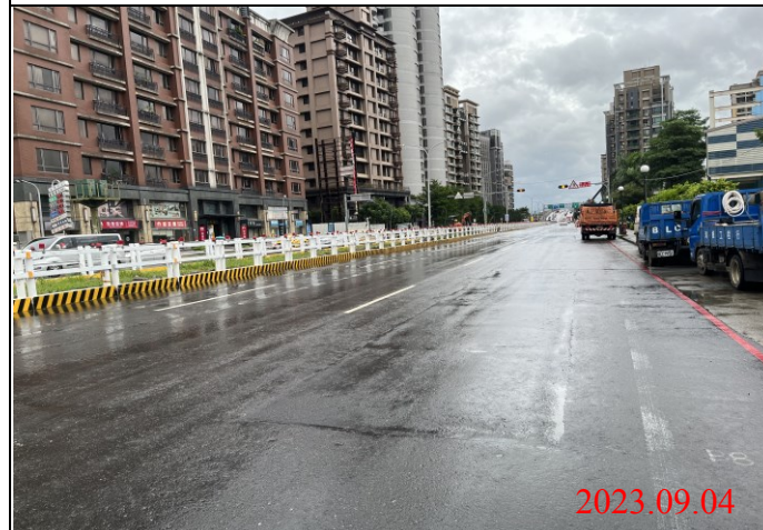
巡查日期地點：112.09.04/ Y23車站 照片說明：路面狀況
