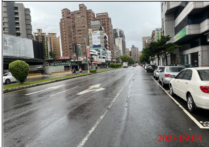
巡查日期地點：112.09.04/ Y21車站 照片說明：路面狀況
