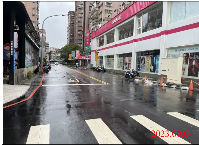
巡查日期地點：112.09.04/ Y21車站 照片說明：路面狀況
