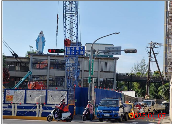
巡查日期地點：114.01.07/ Y21車站 照片說明：牌面設置狀況
