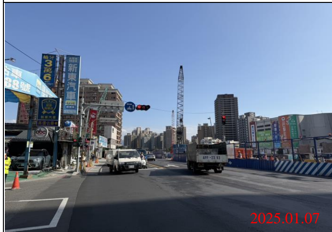
巡查日期地點：114.01.07/ Y22車站 照片說明：牌面設置狀況
