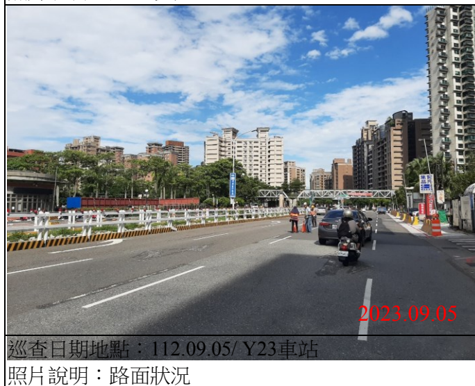
巡查日期地點：112.09.05/ Y23車站 照片說明：路面狀況
