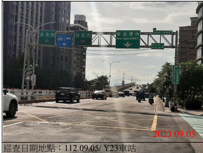
巡查日期地點：112.09.05/ Y22車站 照片說明：牌面設置狀況
