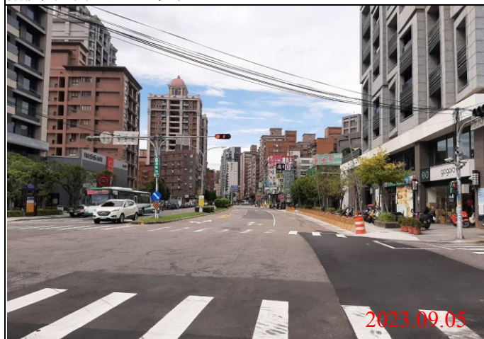
巡查日期地點：112.09.05/ Y22車站 照片說明：路面狀況
