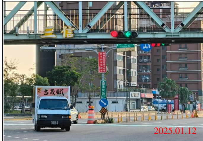
巡查日期地點：114.01.12/ Y23車站 照片說明：牌面設置狀況
