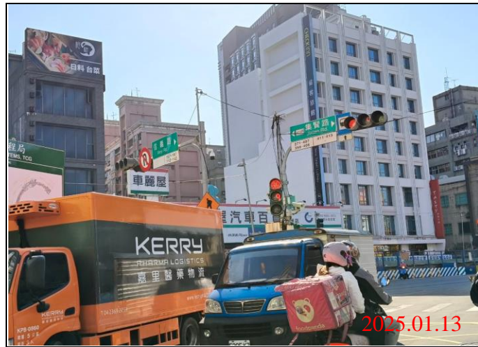
巡查日期地點：114.01.13/ Y21車站 照片說明：牌面設置狀況
