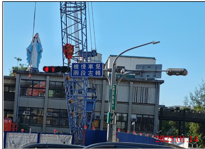
巡查日期地點：114.01.14/ Y21車站 照片說明：牌面設置狀況
