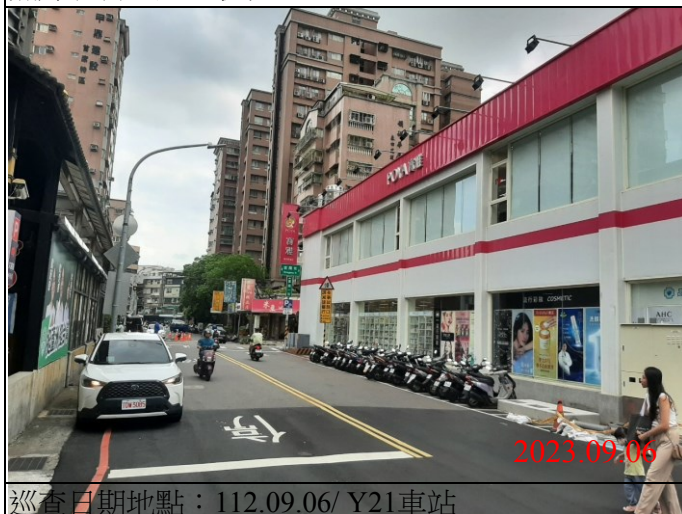
巡查日期地點：112.09.06/ Y21車站 照片說明：路面狀況
