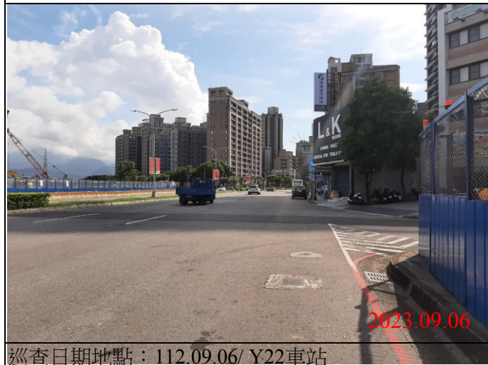
巡查日期地點：112.09.06/ Y22車站 照片說明：路面狀況
