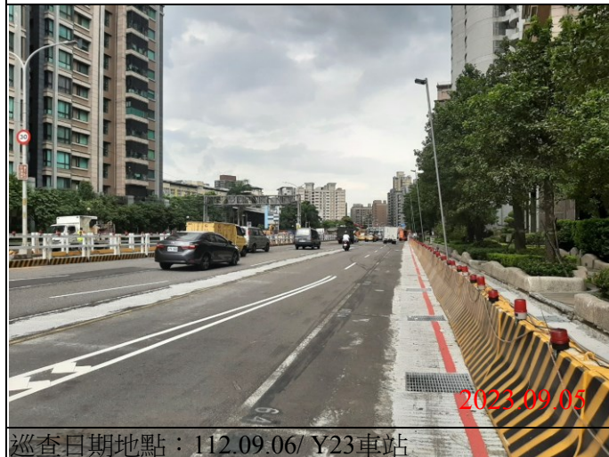
巡查日期地點：112.09.06/ Y23車站 照片說明：路面狀況
