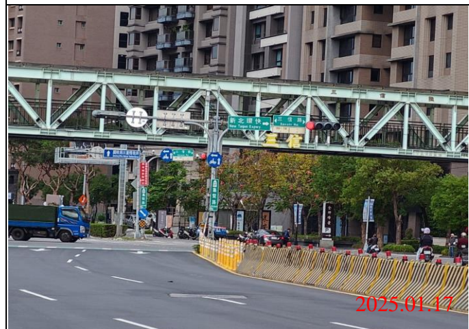
巡查日期地點：114.01.17/ Y23車站 照片說明：牌面設置狀況
