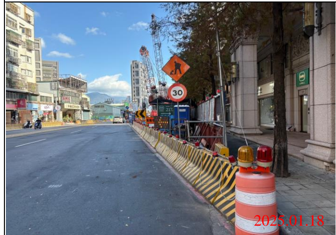
巡查日期地點：114.01.18/ Y22車站 照片說明：牌面設置狀況
