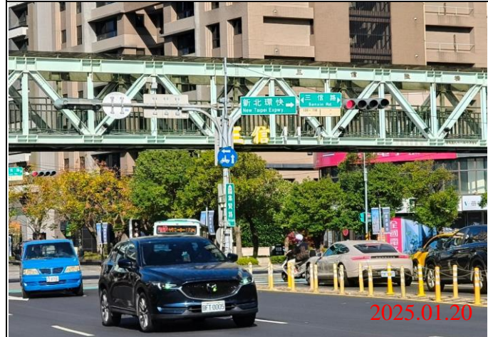
巡查日期地點：114.01.20/ Y23車站 照片說明：牌面設置狀況
