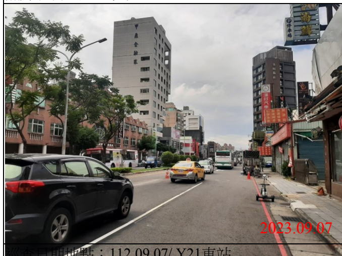
巡查日期地點：112.09.07/ Y21車站 照片說明：路面狀況
