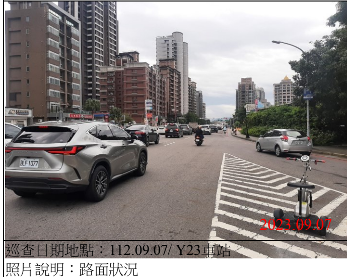
巡查日期地點：112.09.07/ Y23車站 照片說明：路面狀況
