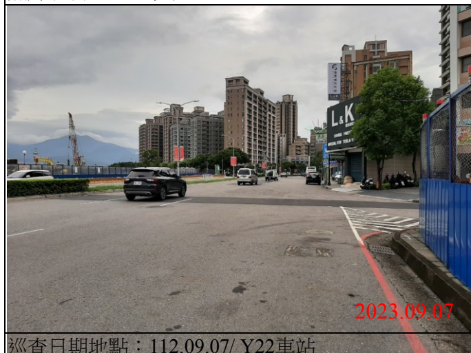
巡查日期地點：112.09.07/ Y22車站 照片說明：路面狀況
