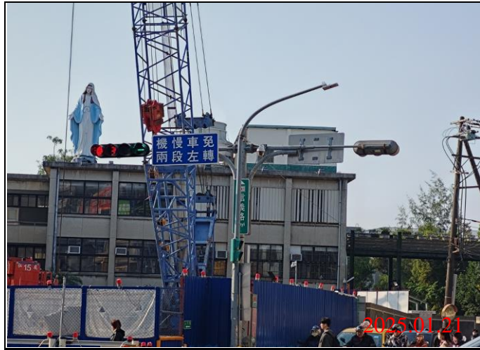
巡查日期地點：114.01.21/ Y21車站 照片說明：牌面設置狀況
