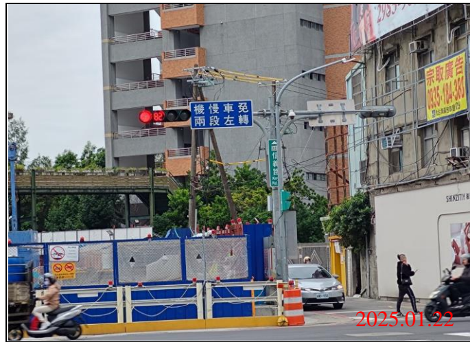
巡查日期地點：114.01.22/ Y21車站 照片說明：牌面設置狀況
