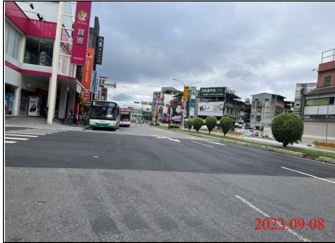
巡查日期地點：112.09.08/ Y21車站 照片說明：路面狀況
