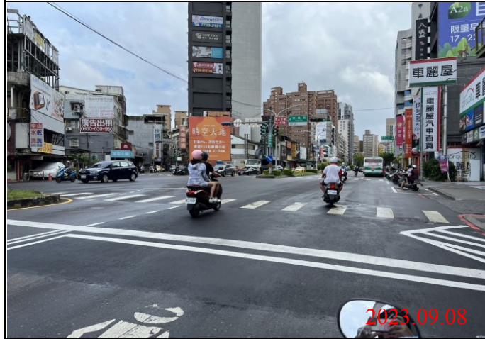
巡查日期地點：112.09.08/ Y21車站 照片說明：路面狀況
