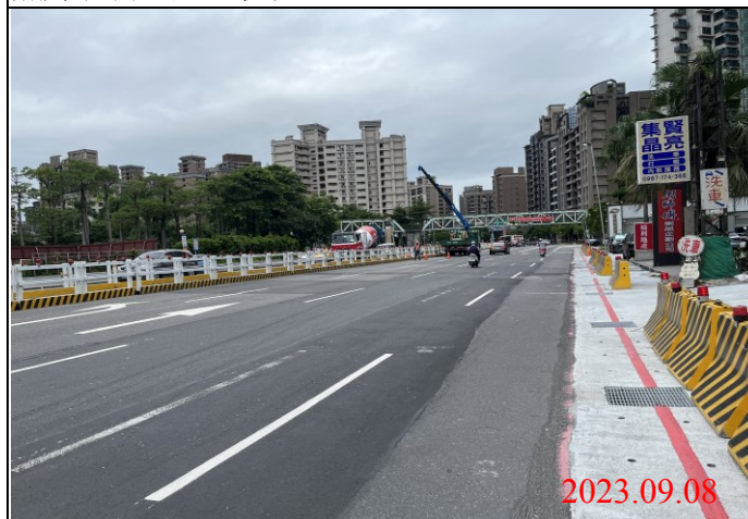
巡查日期地點：112.09.08/ Y23車站 照片說明：路面狀況
