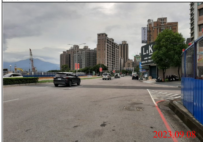
巡查日期地點：112.09.08/ Y22車站 照片說明：路面狀況
