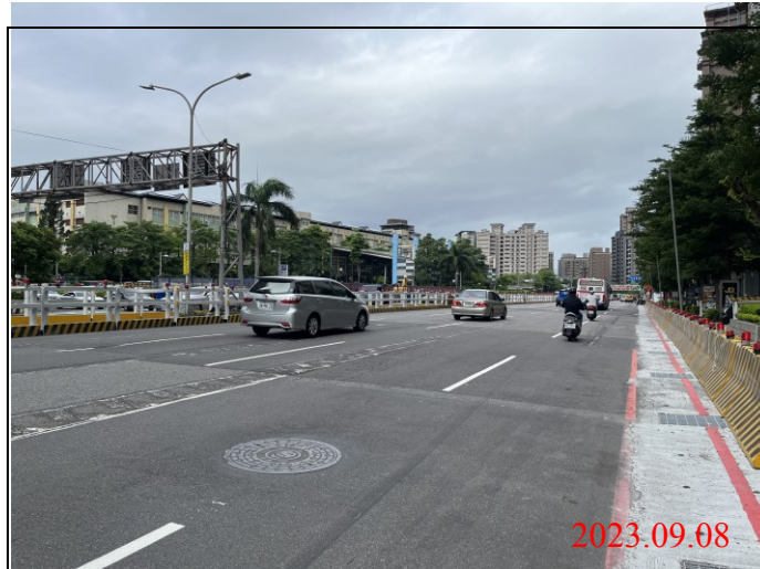
巡查日期地點：112.09.08/ Y23車站 照片說明：路面狀況
