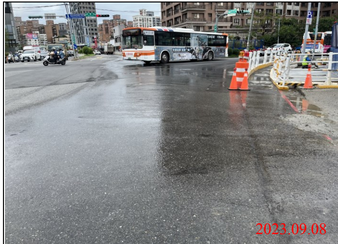
巡查日期地點：112.09.08/ Y22車站 照片說明：路面狀況
