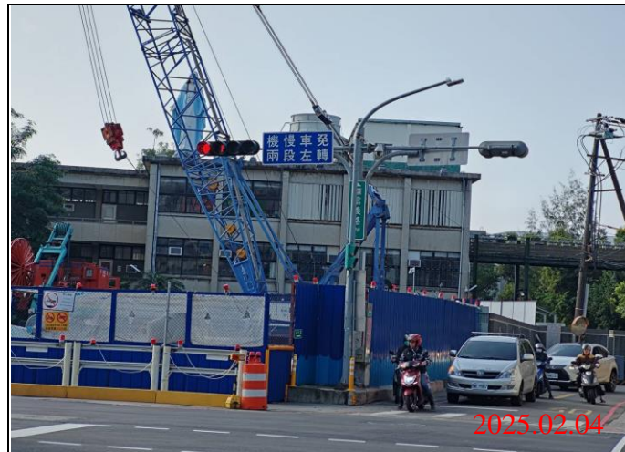
巡查日期地點：114.02.04/ Y21車站 照片說明：牌面設置狀況
