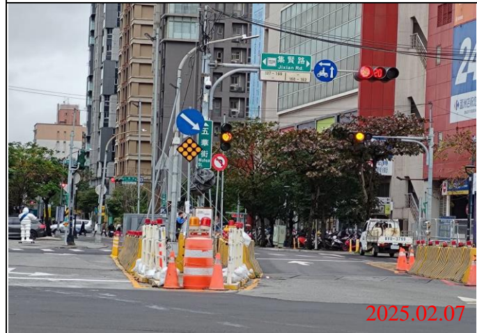
巡查日期地點：114.02.07/ Y22車站
