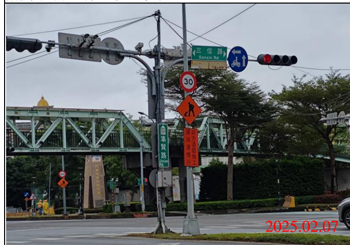
巡查日期地點：114.02.07/ Y23車站
