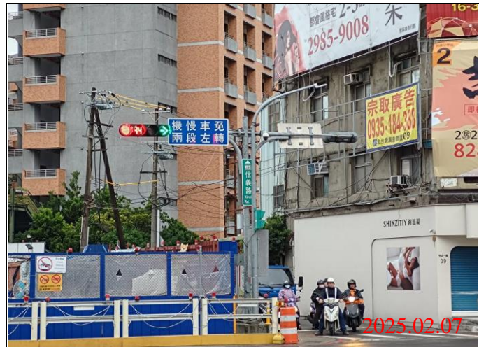
巡查日期地點：114.02.07/ Y21車站
