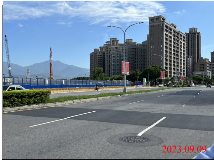
巡查日期地點：112.09.09/ Y22車站 照片說明：路面狀況
