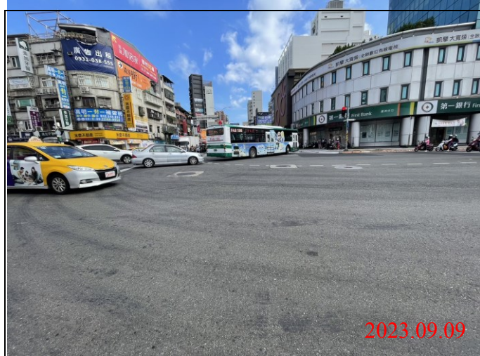
巡查日期地點：112.09.09/ Y21車站 照片說明：路面狀況
