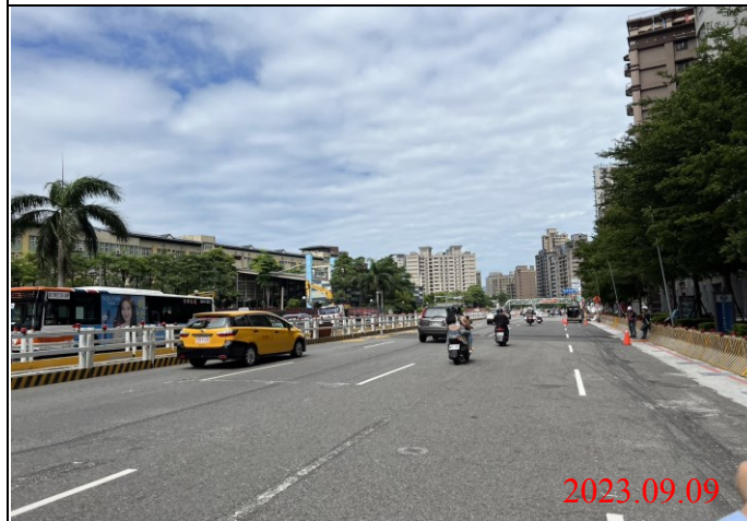
巡查日期地點：112.09.09/ Y23車站 照片說明：路面狀況
