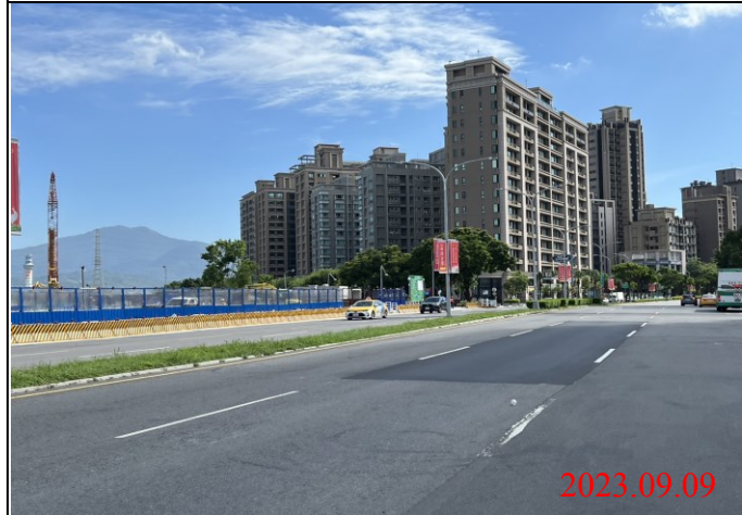
巡查日期地點：112.09.09/ Y22車站 照片說明：路面狀況
