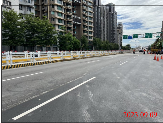
巡查日期地點：112.09.09/ Y23車站 照片說明：路面狀況
