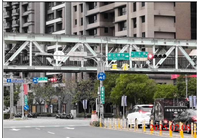
巡查日期地點：114.02.08/ Y23車站 照片說明：牌面設置狀況
