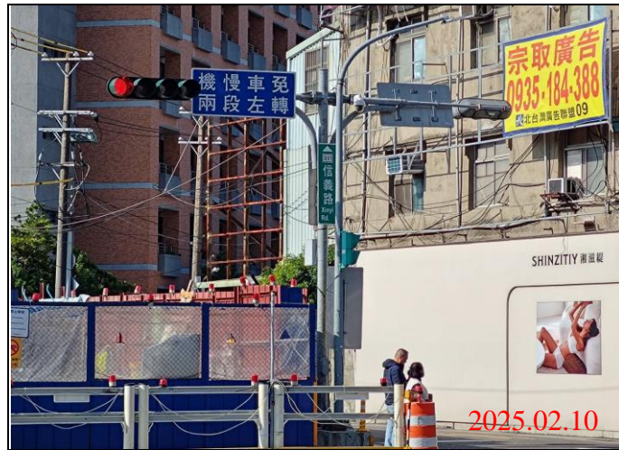
巡查日期地點：114.02.10/ Y21車站 照片說明：牌面設置狀況
