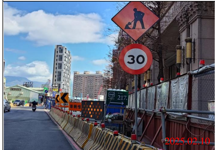
巡查日期地點：114.02.10/ Y22車站 照片說明：牌面設置狀況
