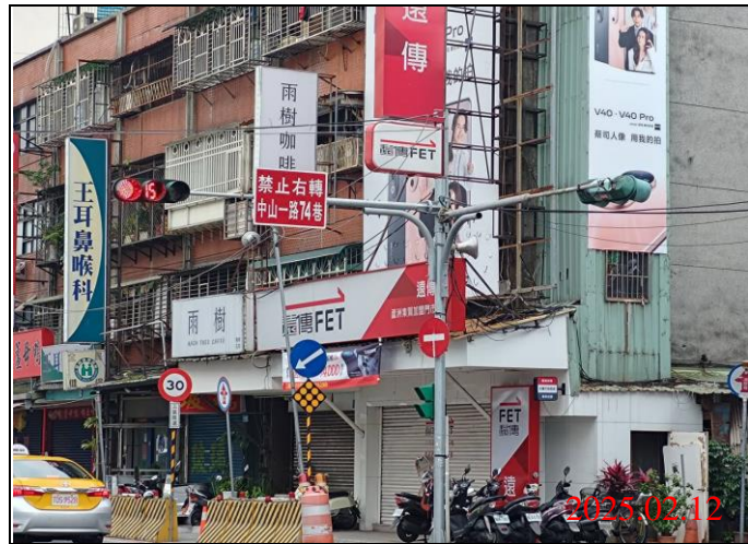
巡查日期地點：114.02.12/ Y21車站 照片說明：牌面設置狀況
