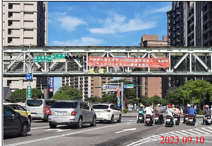
巡查日期地點：112.09.10/ Y23車站 照片說明：牌面設置狀況
