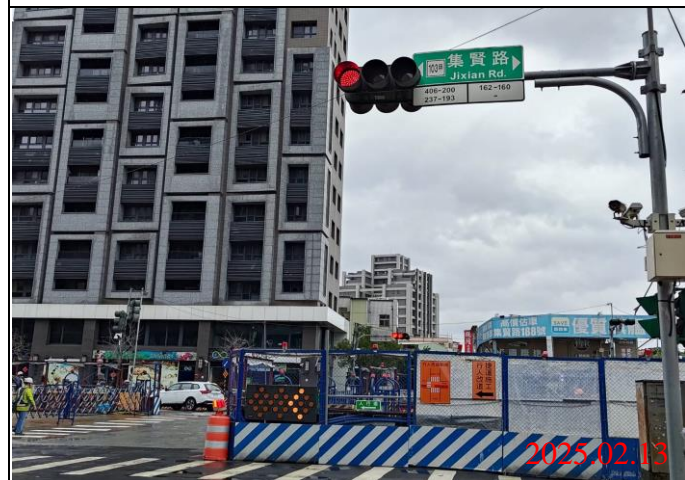
巡查日期地點：114.02.13/ Y22車站 照片說明：牌面設置狀況
