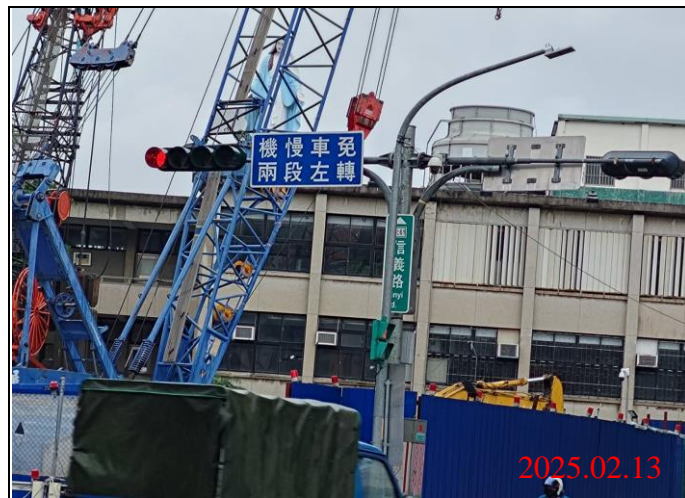
巡查日期地點：114.02.13/ Y21車站 照片說明：牌面設置狀況
